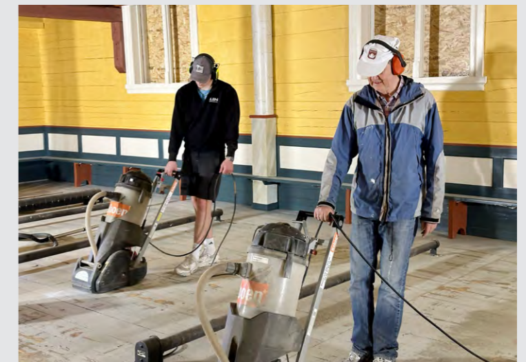
Arbeid med å slipa ned golvet i kyrkja.
